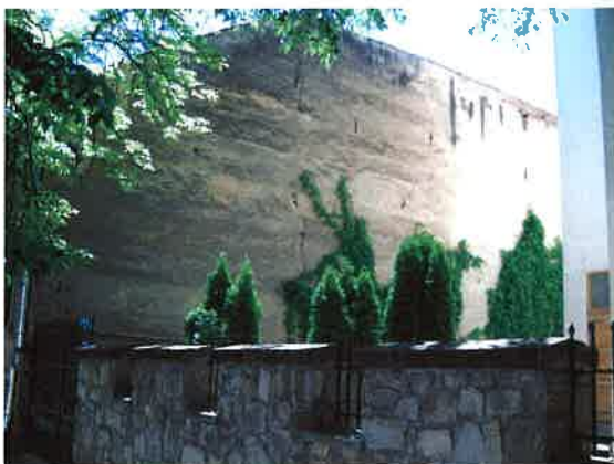
Latura dinspre biserica unitariană, cu o crăpătură cvasiverticală
