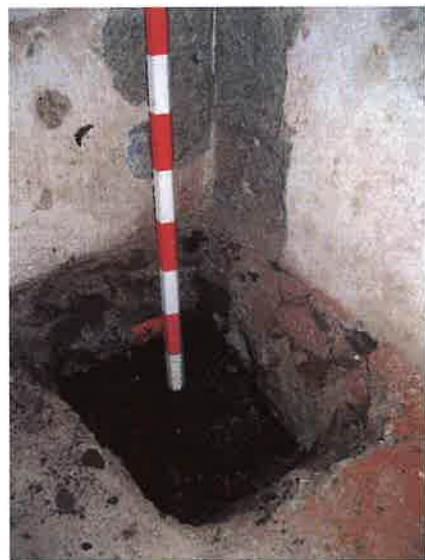
Fundația dezvelită în subsol
